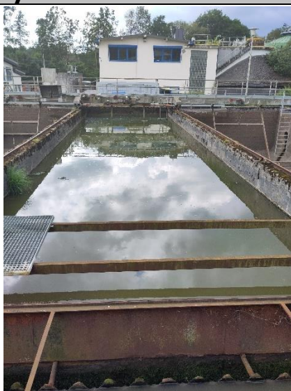
Figure 21 : Bassin de sédimentation
