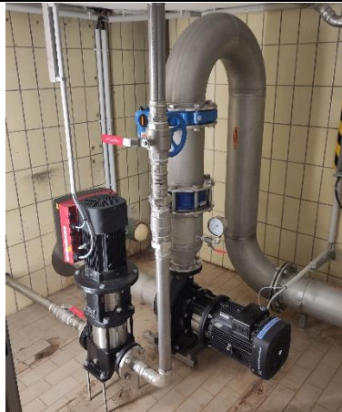
Figure 17 : Pompe pour le nettoyage des filtres (à droite)
