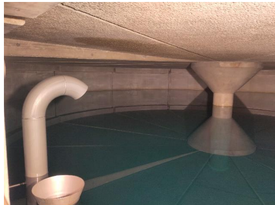
Figure 16 : Bassin 3 d'eau potable
